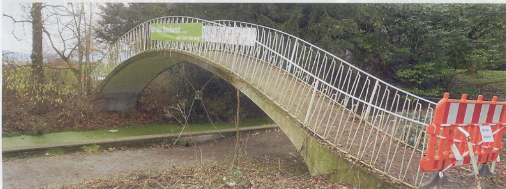
Eine fachmännische Prüfung soll zeigen, ob die Brücke im Lindenhofbad erhalten bleiben kann. BZ-Foto: WV
